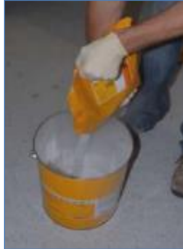
Imagen 5: Mezclado de Grout
