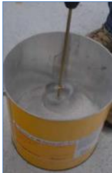
Imagen 6: Mezclado de Grout
